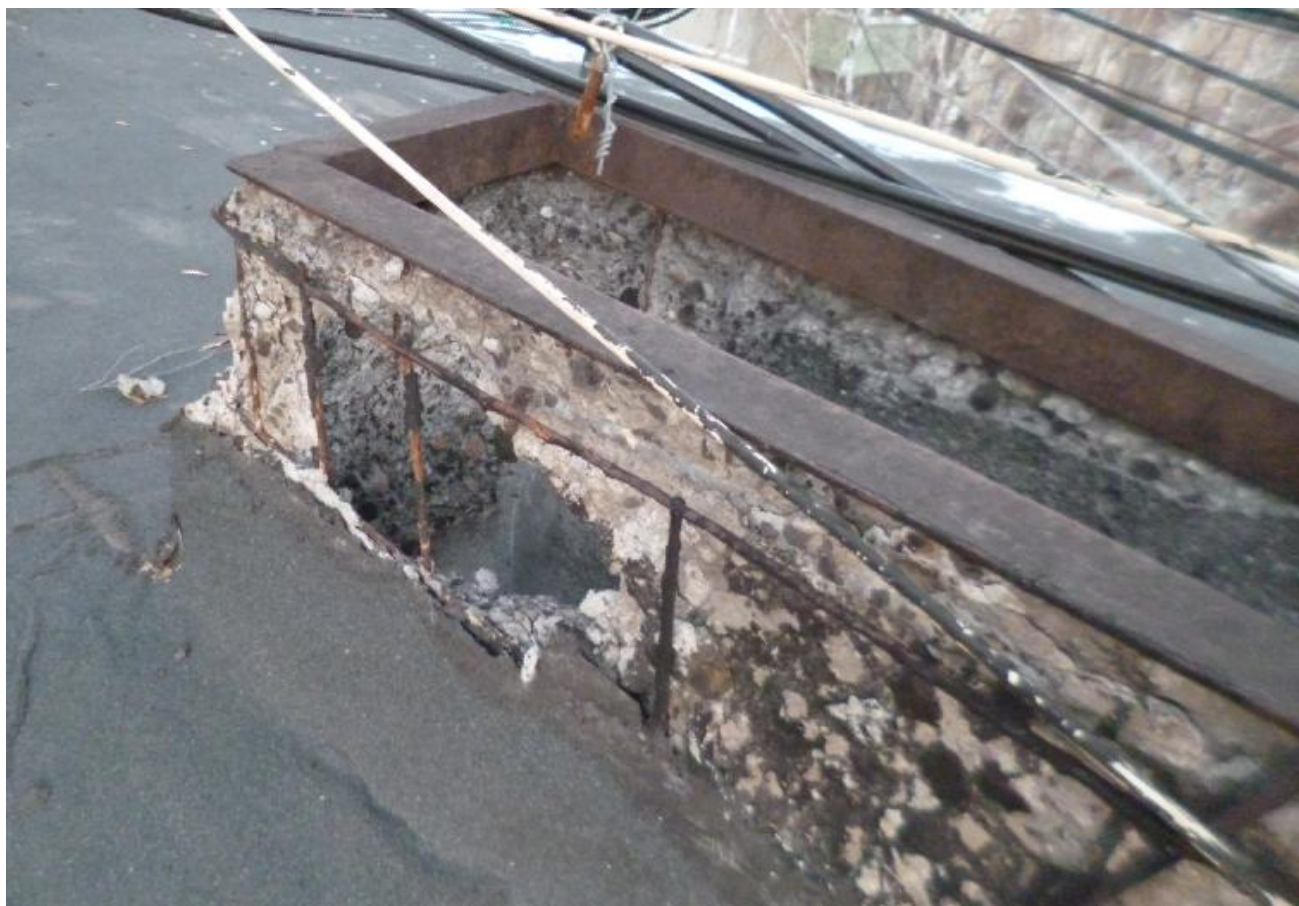
Фото 3. Вентканалы. Примыкание кровельного ковра.
