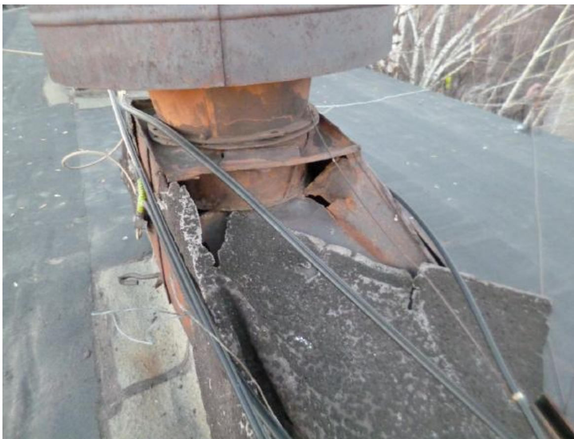
Фото 4. Разрушение дефлекторов и металлических кожухов
