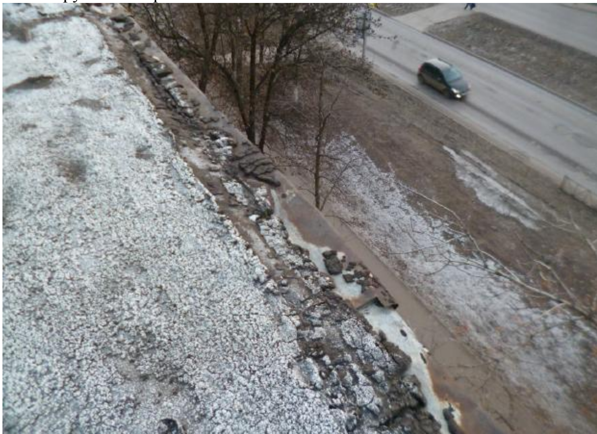
Фото 5. Разрушение карнизных металлических отливов.
