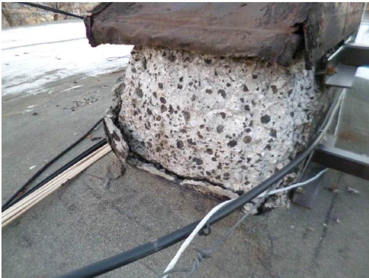
Фото2. Вентканалы, разрушение стен.
