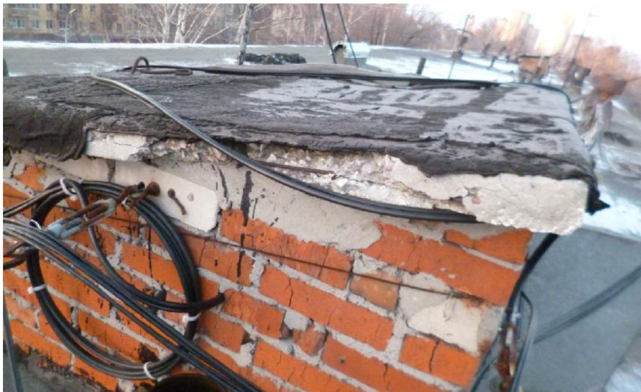
Фото 7. Разрушение кровельного ковра будок выхода на кровлю.
