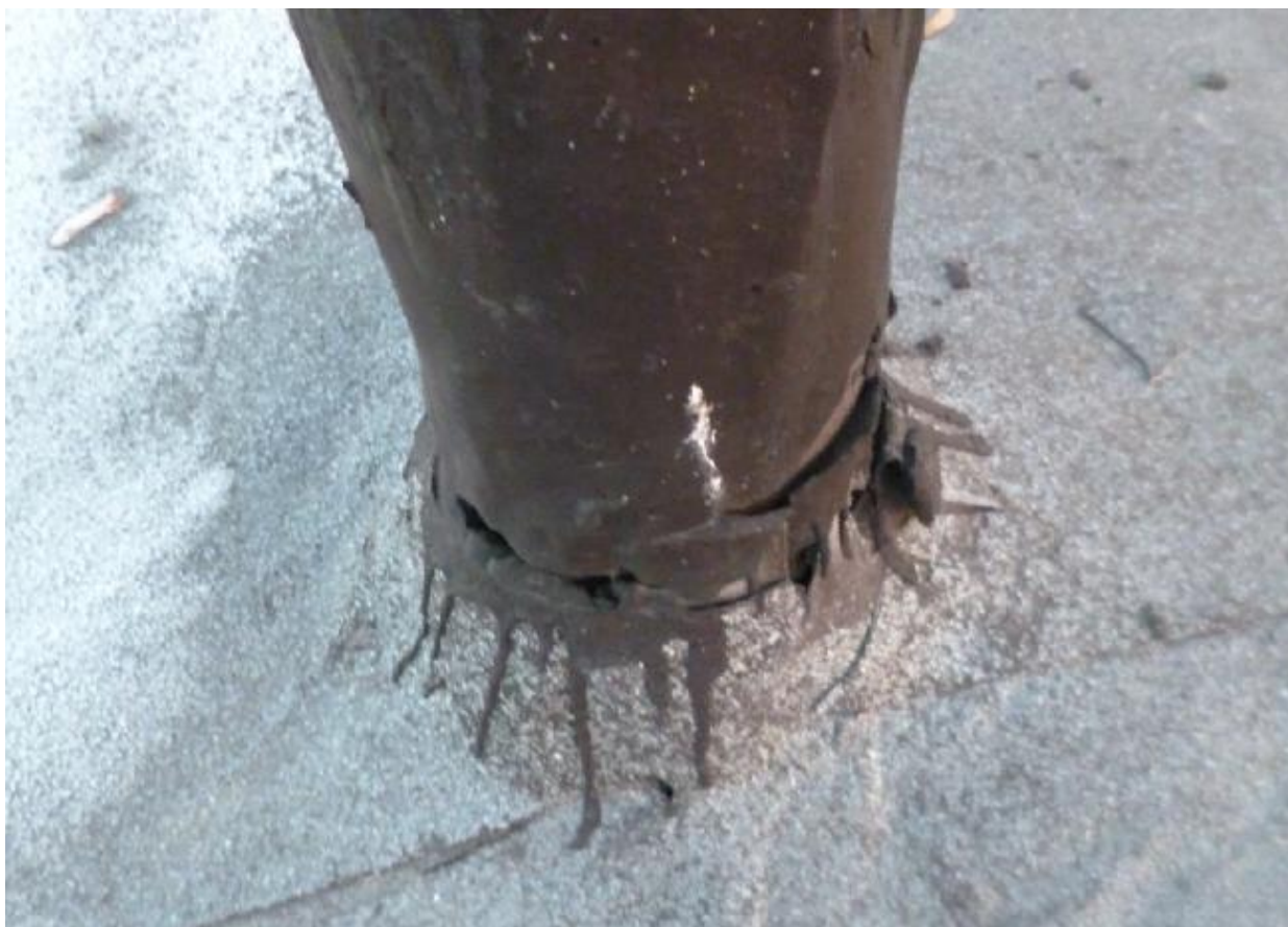
Фото 6. Разрушение фановых труб и примыкания кровельного ковра
